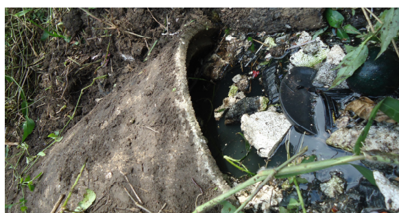
Figura 2. Despejo da rede de esgoto no lago. Fonte direta, 2010
