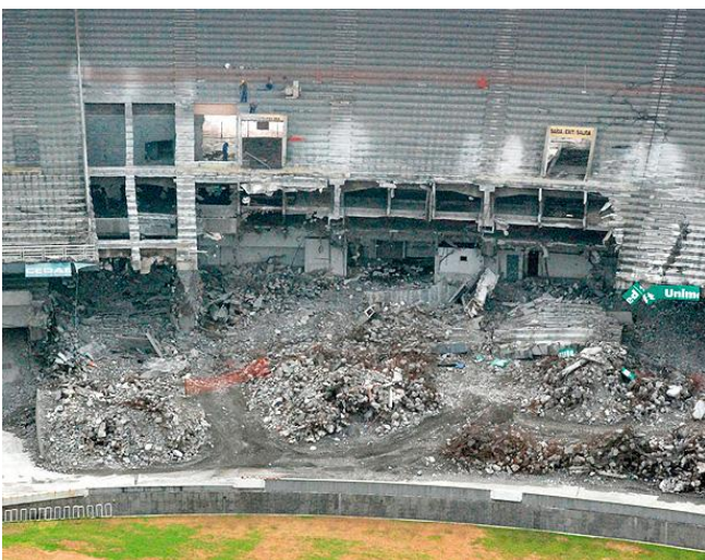
Arquibancadas do Maracanã estão sendo demolidas para obras de reforma, gerando o entulho. (Foto: Genilson Araújo)
