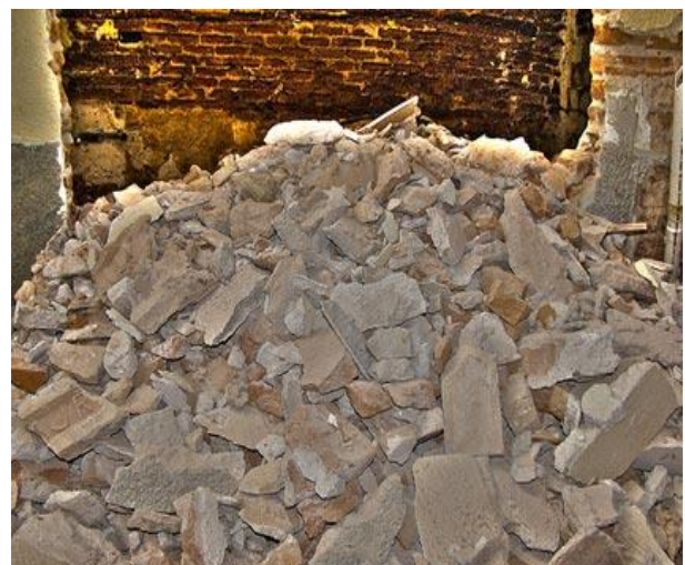
Entulho gerado da demolição de uma casa. (Foto: Tadeu Pereira)
