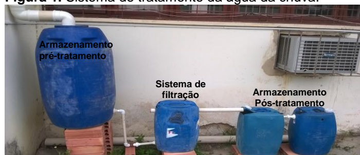
Figura 1. Sistema de tratamento da água da chuva.
