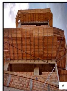
no fato de que no perímetro da construção de edifícios com mais de 4 (quatro) pavimentos ou altura equivalente, é obrigatória a instalação de uma plataforma principal de proteção na altura da primeira laje. Por outro lado, em nenhuma delas foi verificada a tela de proteção e nas obras A e B a ausência de guarda corpo em algumas partes da laje.
