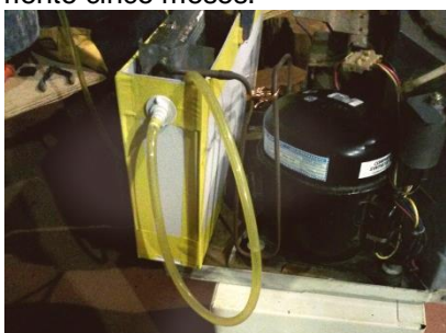
Figura 1. Montagem do ar condicionado
