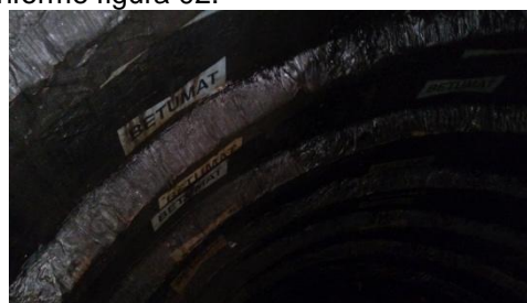
Figura 02. Manta asfáltica existente, estado de destacamento nas juntas dos anéis.
