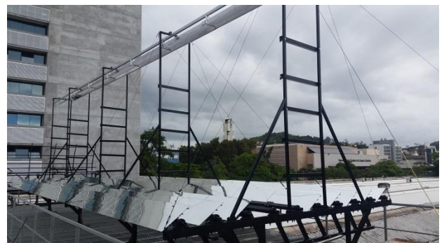
Figura 1 – Coletor Fresnel linear em construção pelo laboratório LEPTEN na UFSC
