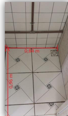
Figura 2 - Área do boxe do banheiro Fonte: Autoras
