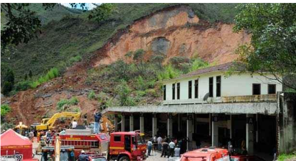
Figura 1 - Deflagração de um talude destruindo parte do terminal rodoviário de Ouro Preto. FONTE: [5]
