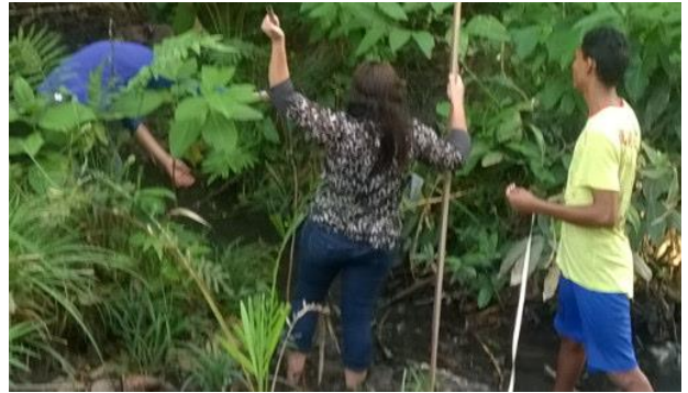
Figura 2. Visita em áreas para instalação do carneiro hidráulico.
