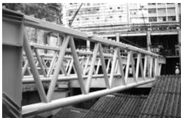
Figura 1 – Exemplo ilustrativo de ligação tubular tipo K
