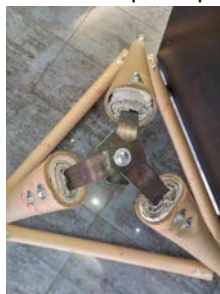
Figura 5 – Ligação em aço no tetraedro espacial de tubos de papelão, Fonte: autores.
